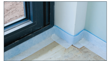
c Fit edge expansion strip.
